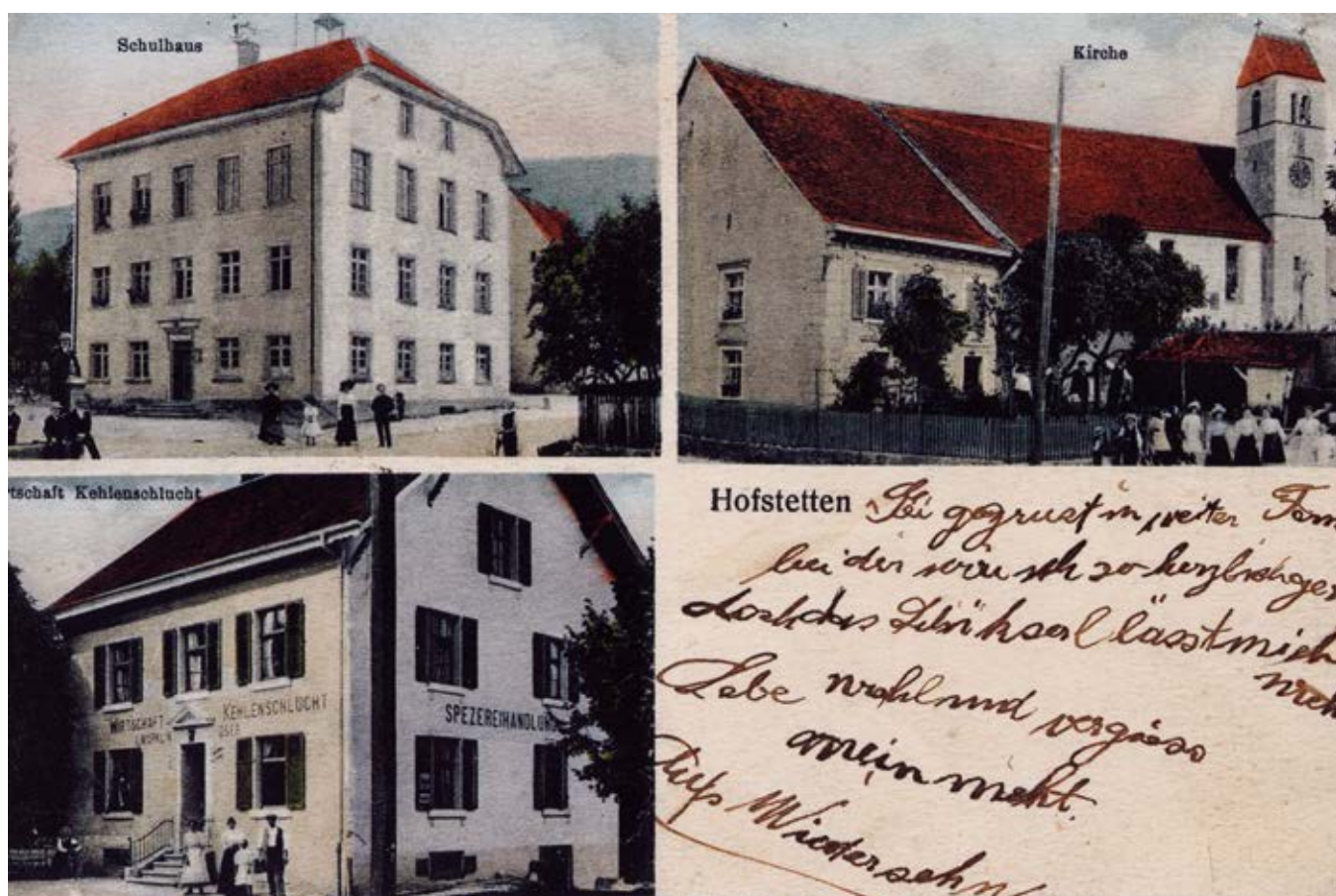
Das alte Schulhaus in Hofstetten wurde 1879/80 um einen Stock erhöht.
