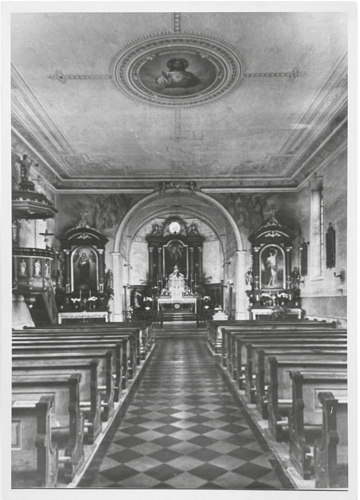
Der Innenraum der Pfarrkirche Hofstetten, gestaltet nach dem Zeitgeschmack des 19. Jahrhunderts.
