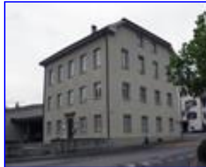
Neubau auf Schulhausareal in Hofstetten
