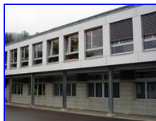
Umbau + Renovation Schulhaus Flüh
